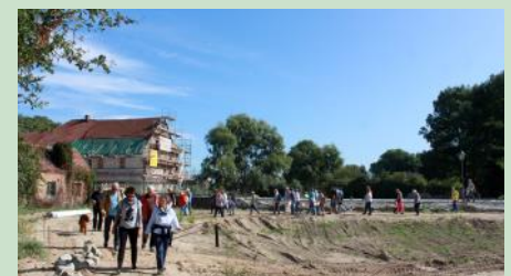
Auf dem Klärwerksgelände und an der Wassermühle, dort wo der Mühlenteich neu entsteht.
